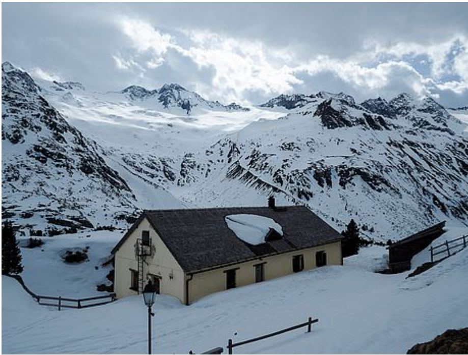
Winterraum der Berliner Hütte
